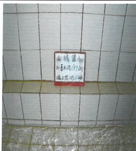
行政大樓 B1F 蓄水池施工前
