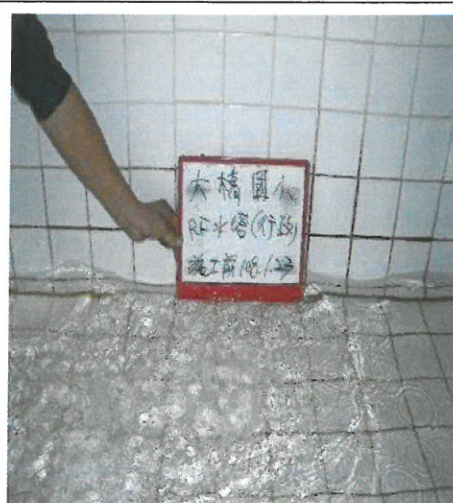
行政大樓 水塔施工前
