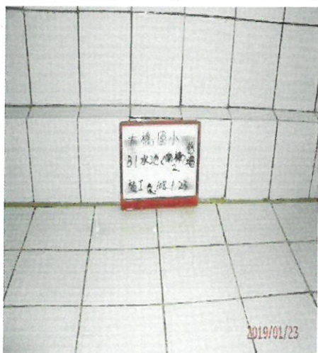
南棟 B1F 蓄水池-2 施工後
