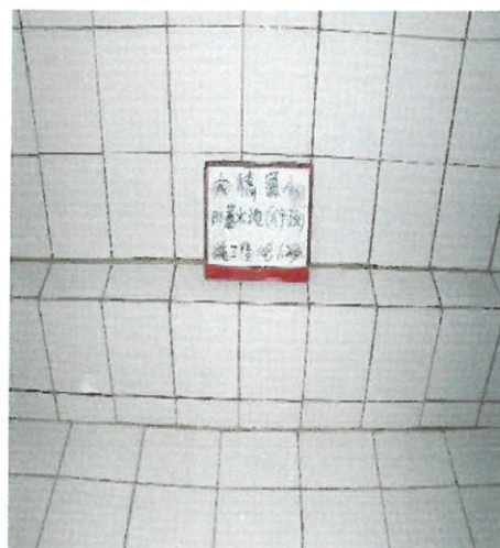
行政大樓 B1F 蓄水池施工後
