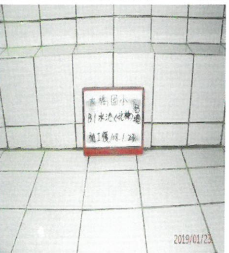
北棟 B1F 蓄水池施工後
