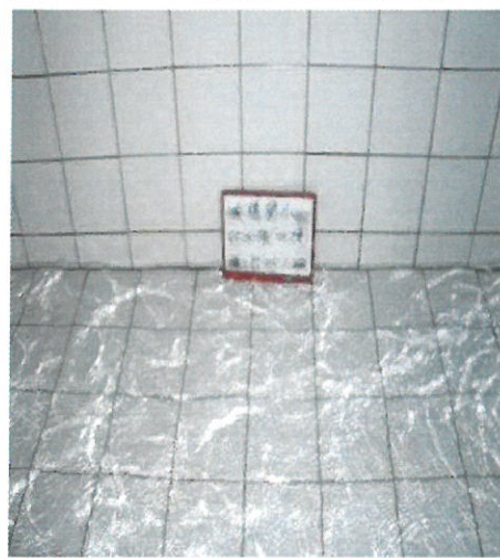
北棟 水塔施工前
