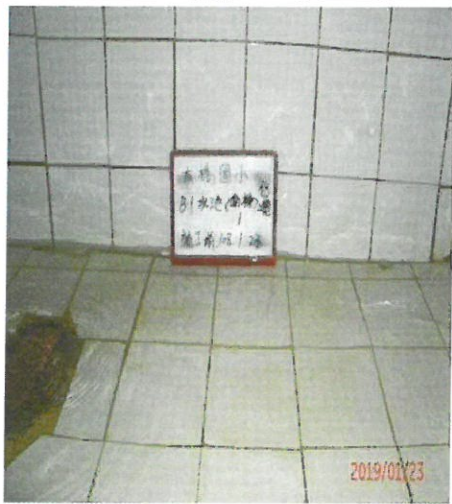
南棟 B1F 蓄水池-1 施工前
