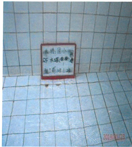
南棟 水塔-1 施工前
