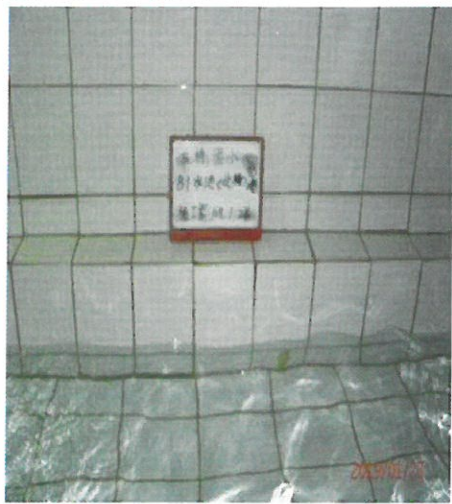
北棟 B1F 蓄水池施工前
