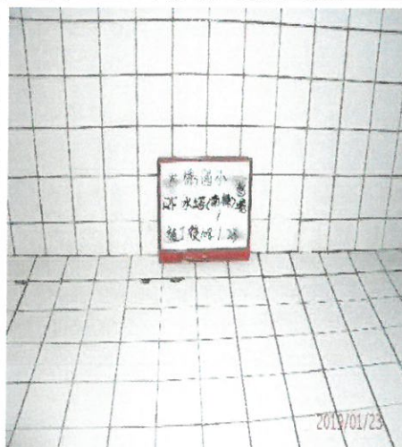
南棟 水塔-1 施工後
