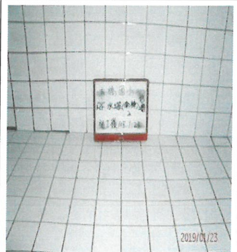
南棟 水塔-2 施工後
