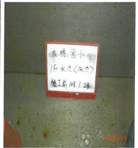
游泳池 1F (平衡池) 施工前
