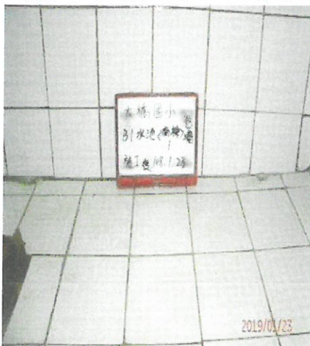
南棟 B1F 蓄水池-1 施工後
