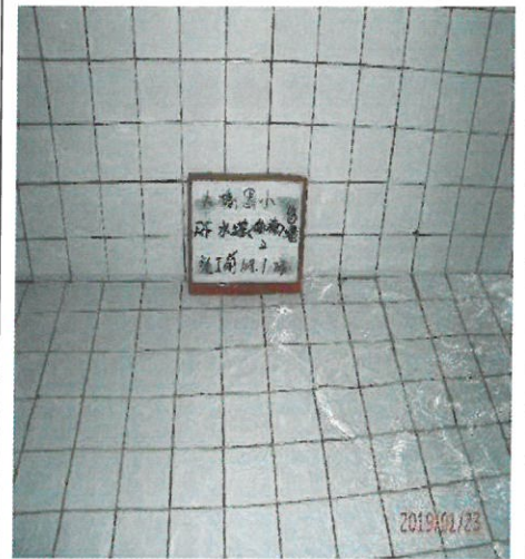
南棟 水塔-2 施工前
